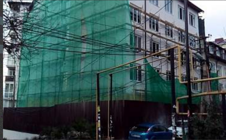
г. Сочи, ул. Верхняя Лысая гора
